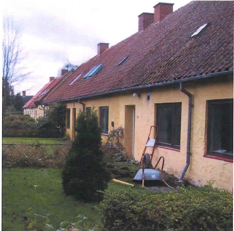
Arbejderboligerne på Favrbvej relaterer sig direkte til Stenværkstedet Geflon og til havnen. Bebyggelsen er opført i kalksten i 1852 og er blandt det ældste bevarede byggeri i Fakse Ladeplads.
